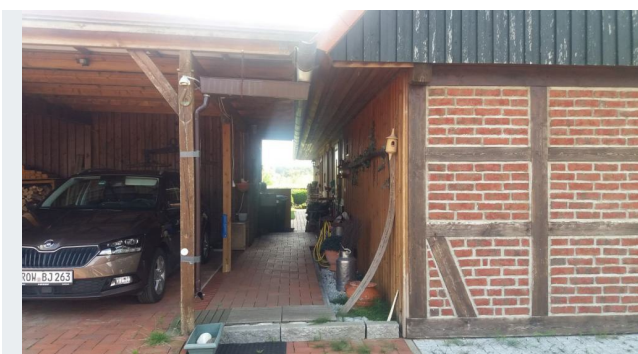
Carport mit Durchgang zum Haus
